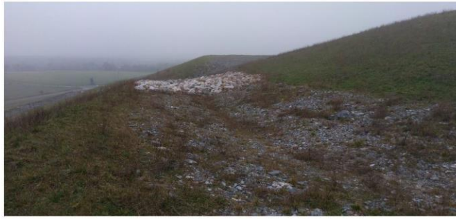
Piste et enrochement actuellement présents sur le merlon
